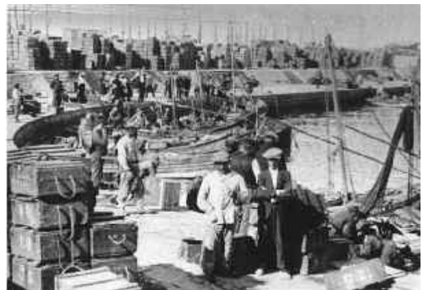
Los trabajadores de la pesca ya construido el Puerto
