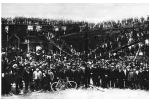
Trabajadores de la construcción de la Rambla Nueva, de material y estilo francés
